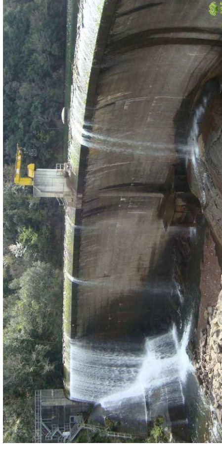
Photographie 3 : Le barrage des Cambous (avril 2019)
