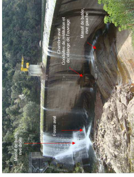
Figure 3 : Principales opérations sur le barrage des Cambous
